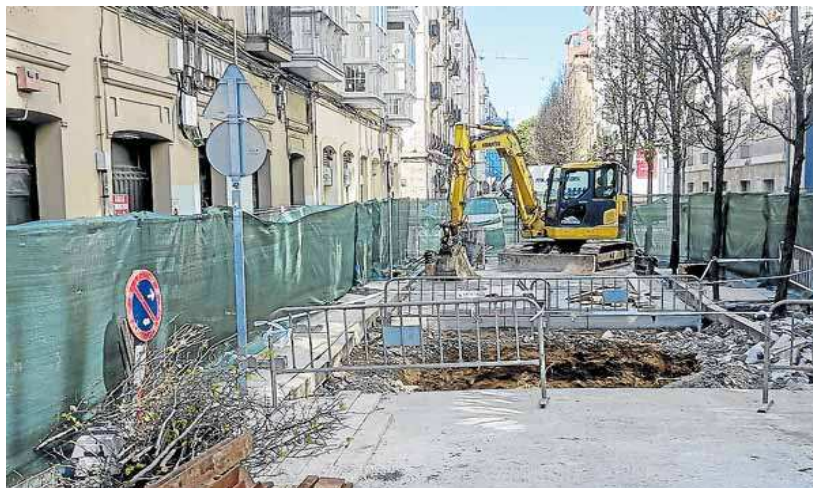
La calle Ataúlfo Argenta, ayer, cerrada al tráfico por las obras, que durarán un mes. ROBERTO RUIZ
