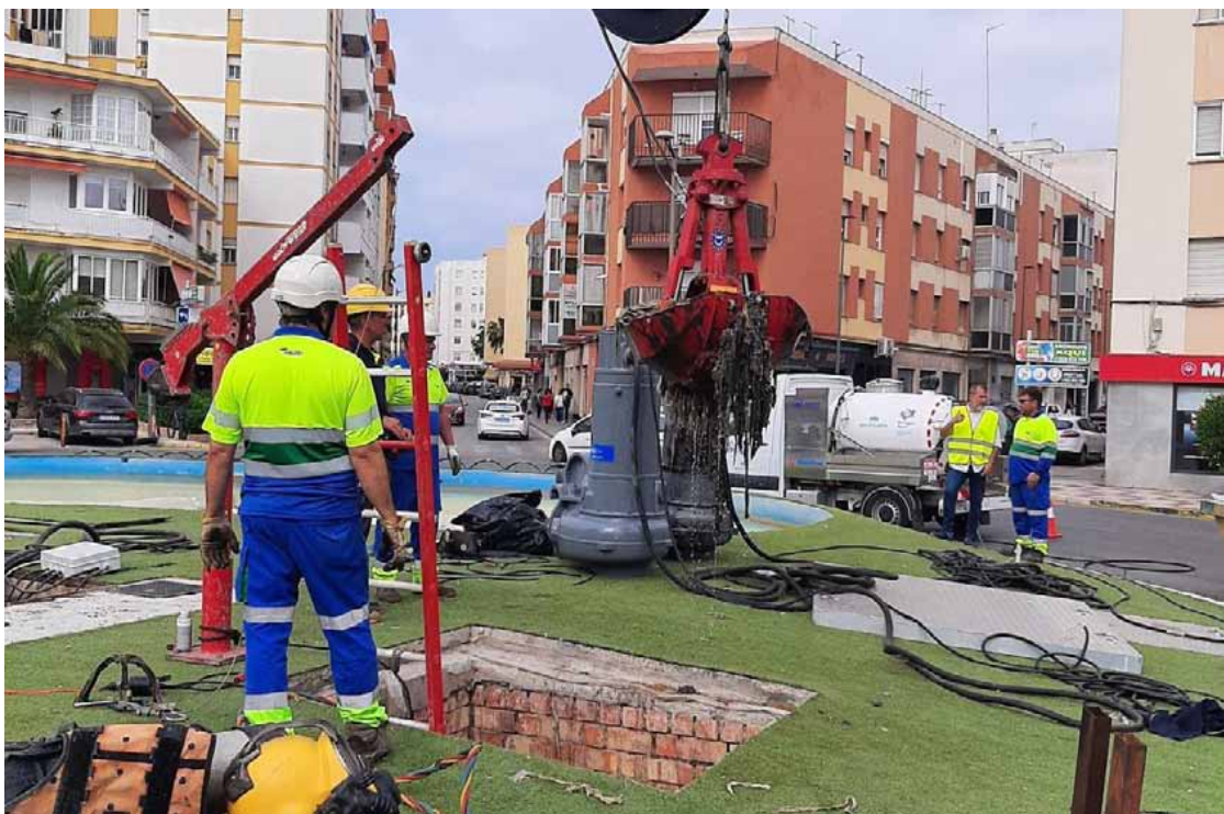
Limpieza de la Estación de Bombeo de Aguas Residuales (EBAR) de la Plaza de la Noria en El Puerto.
