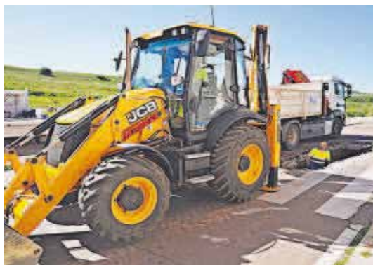
Los operarios de la adjudicataria durante el arreglo de la avería. LAYA
