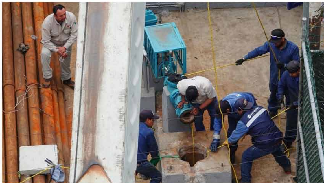
Trabajadores realizan labores de limpieza en el Pozo Alfonso XIII, un punto de contaminación del agua potable de la alcaldía Benito Juárez, el 11 de abril. Rogelio Morales Ponce (Cuartoscuro)
