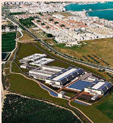
Desaladora de Torrevieja, en Alicante.
